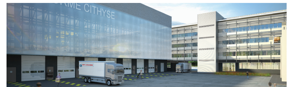
Halle technologique côté cour
