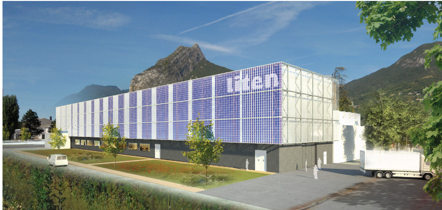
Liten – Halle technologique côté autoroute-CEA-TECH
