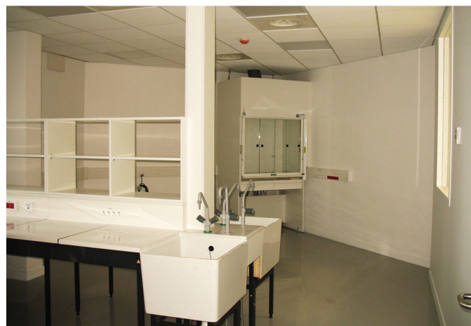
Mise en place des sorbonnes
