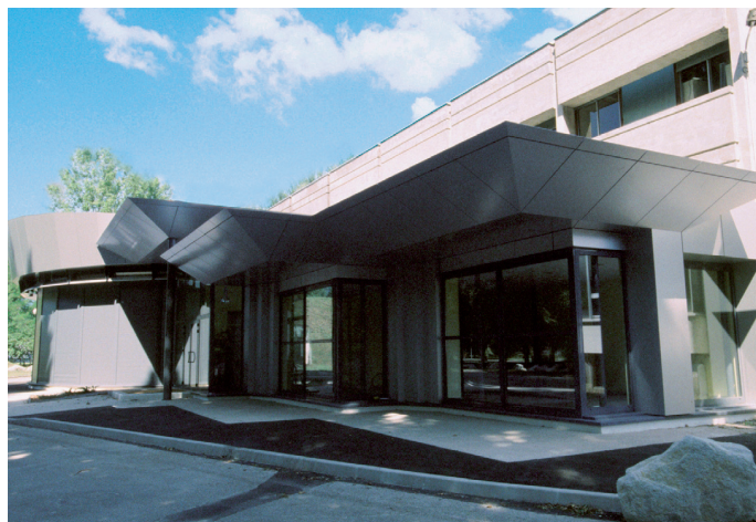
Vue façade sud-ouest
