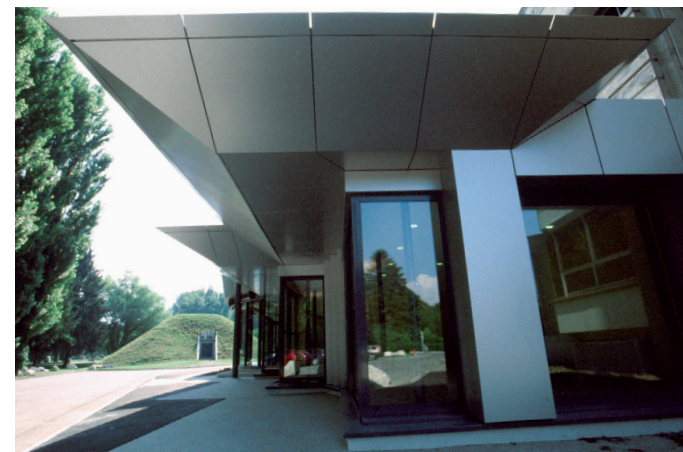
Extension du bâtiment – Façade est
