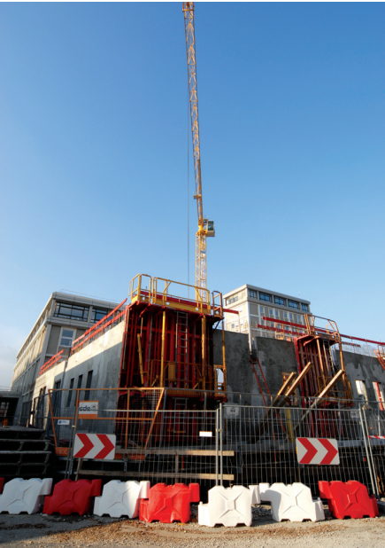
Détail chantier en 3 tranches
