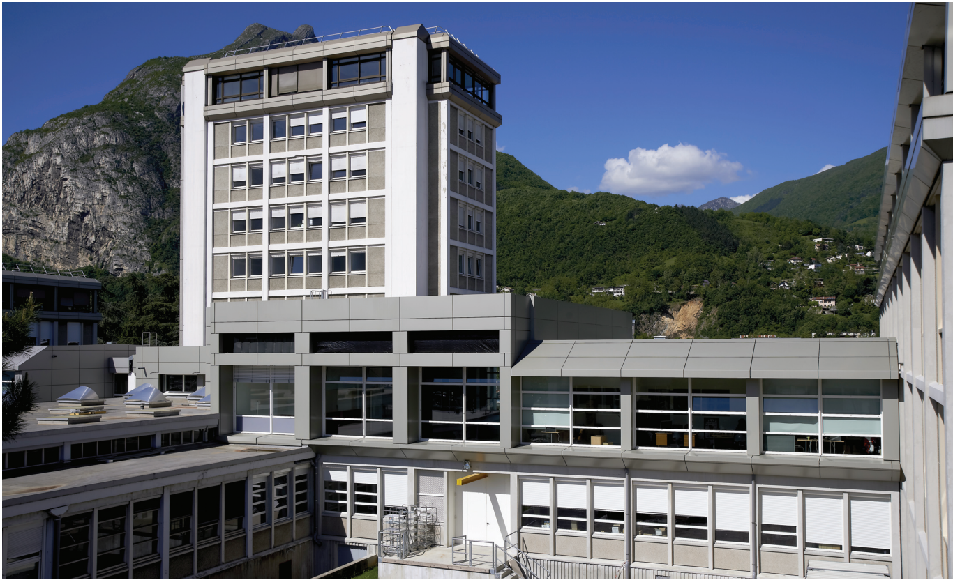
Surélévation / extension du bâtiment C1
