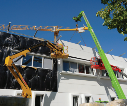
Montage des panneaux en CCV composite
