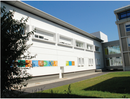
Détail façade ouest bâtiment scientifique Z
