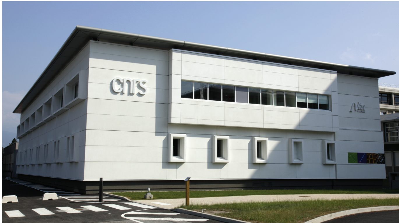
Fronton d'accueil du bâtiment scientifique « Z »
