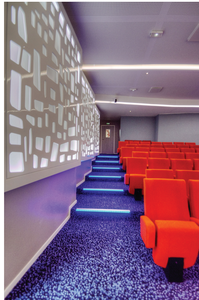
Détail des panneaux acoustiques décoratifs
