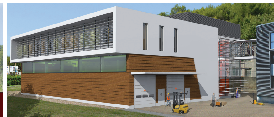
Bâtiment N° 12 ateliers/bureaux/archives
