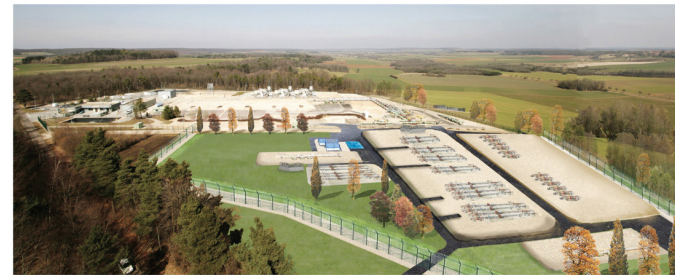
Restructuration du site industriel – Voisines (52)
