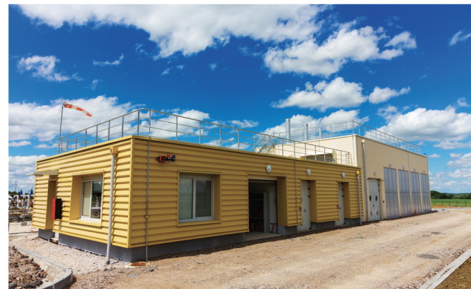
Bureaux et chaudière – Valhuon
