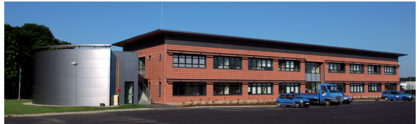
Vue générale bâtiment tertiaire
