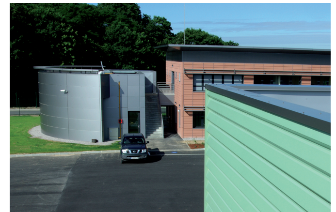
Jonction salle de contrôle
