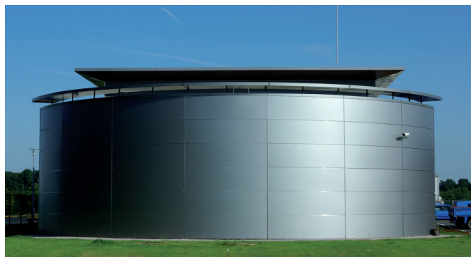
Détail façade de la salle de contrôle
