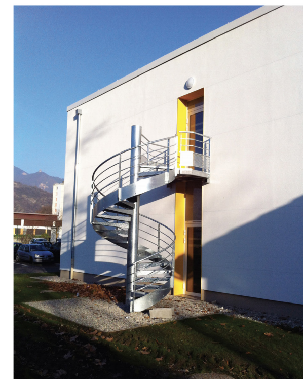
Escalier de secours
