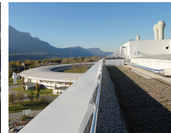
Toiture terrasse technique
