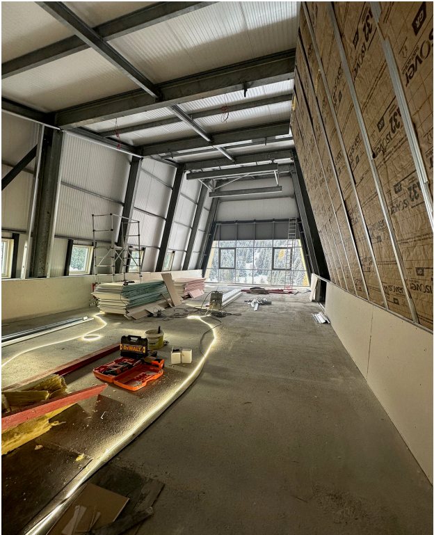
| Chantier en cours / Isolations thermique et coupe-feu
