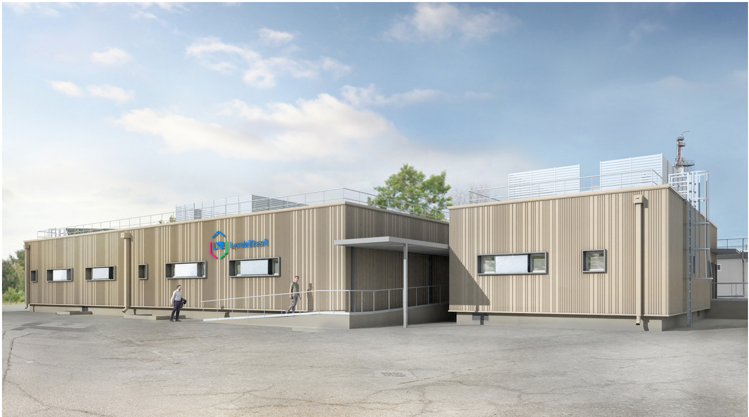
| Bâtiment vestiaires mixtes / Détail entrée
