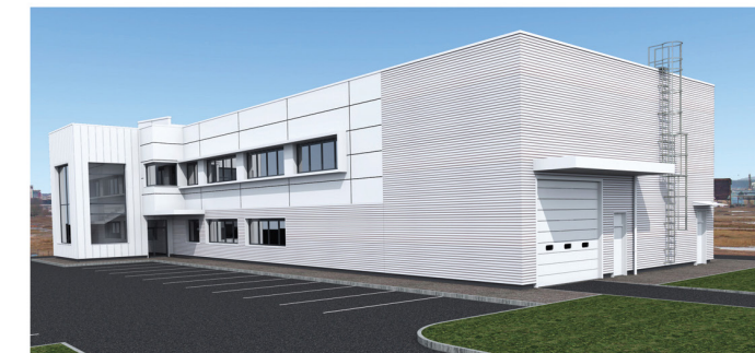
Entrée atelier montage
