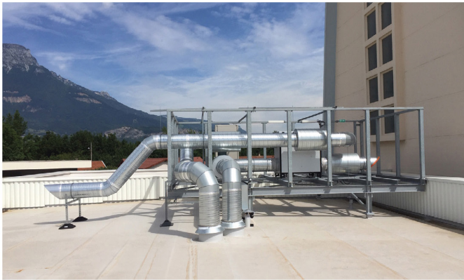
Détails structure support/Chauffage ventilation climatisation
