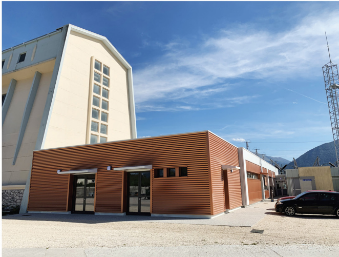
Entrée des ateliers/vestiaires
