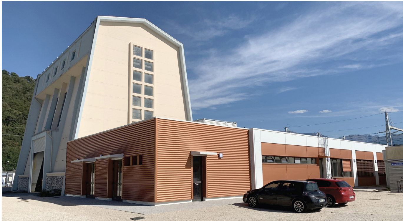
Bâtiment tertiaire/vestibaire/ateliers - Bâtiment 8 angle Nord-ouest
