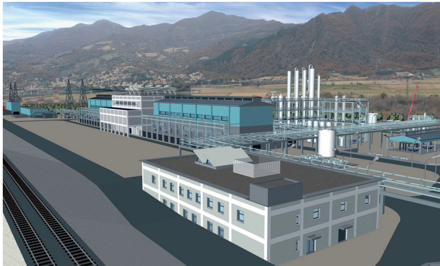
Détail usine première tranche 4 000 T
