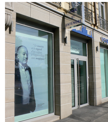
Détail de l'entrée
