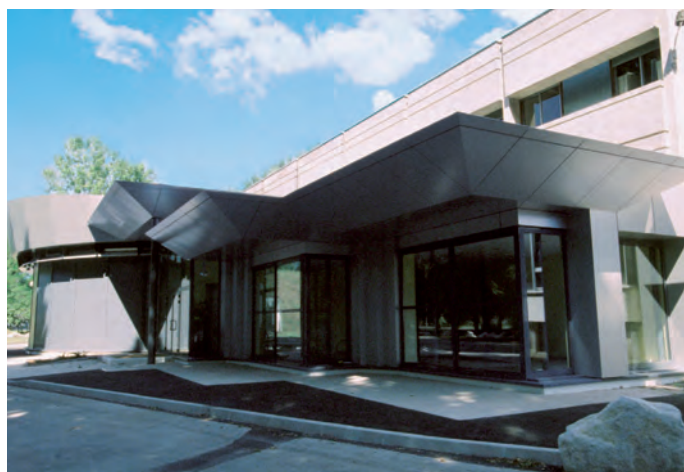
Vue façade sud-ouest
