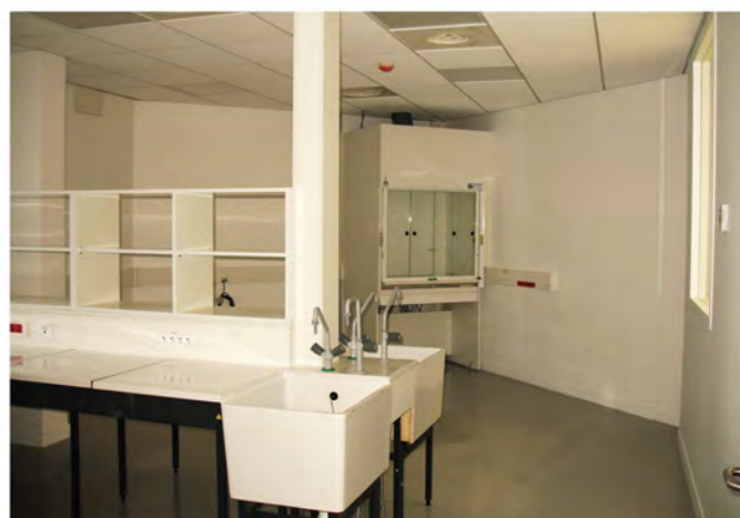
Mise en place des sorbonnes
