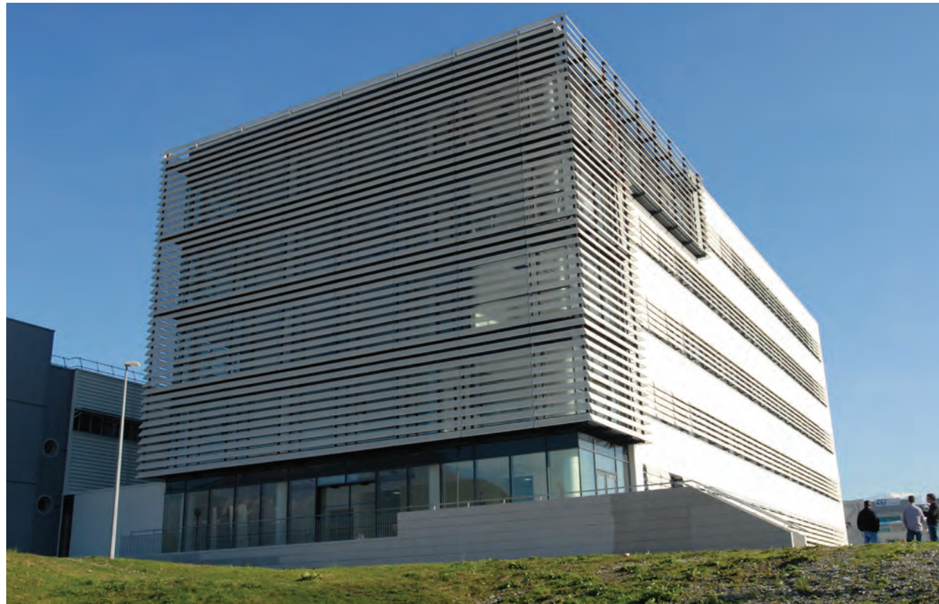
Vue du bâtiment « Science Building »
