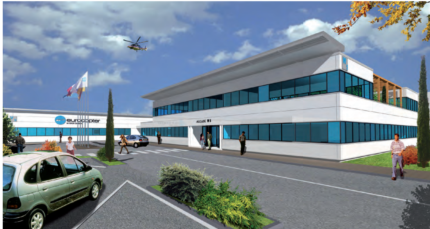
Bâtiment accueil clientèle / Livraison hélicoptères / 2008
