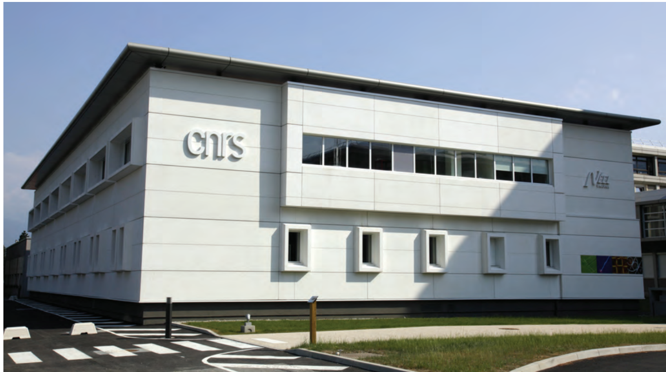
Fronton d'accueil du bâtiment scientifique « Z »
