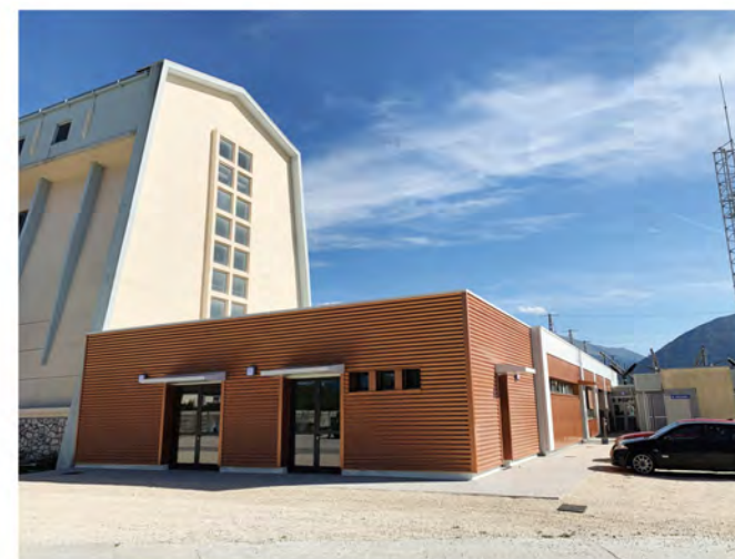
Entrée des ateliers/vestiaires
