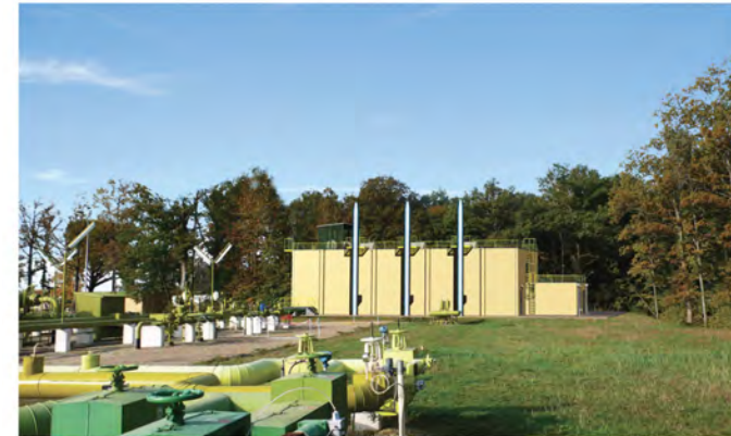
Chaudière industrielle – Etrez (01)
