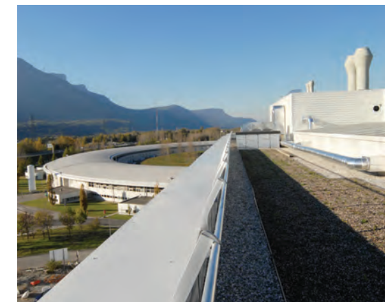
Toiture terrasse technique
