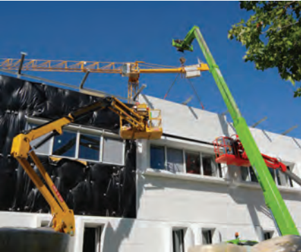
Montage des panneaux en CCV composite
