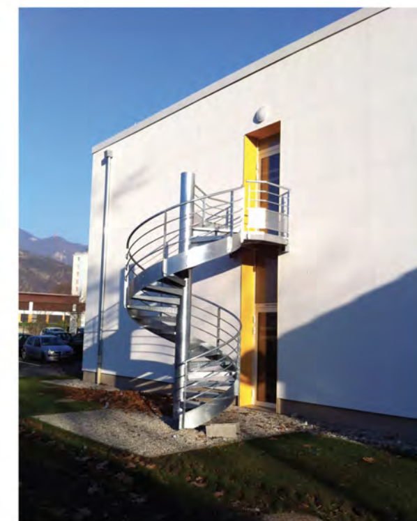
Escalier de secours
