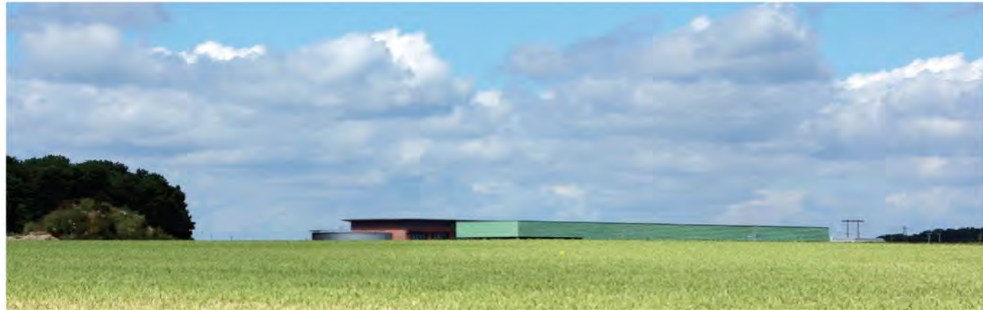
Insertion dans le site du programme industriel – Parc national du Vexin – Saint-Clair-sur-Epte (95)
