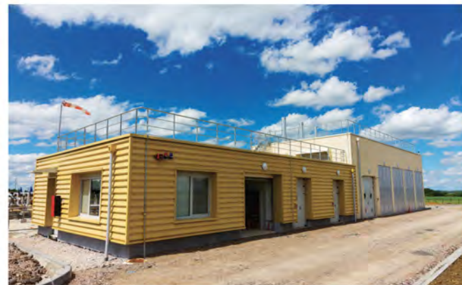
Bureaux et chaudière – Valhuon
