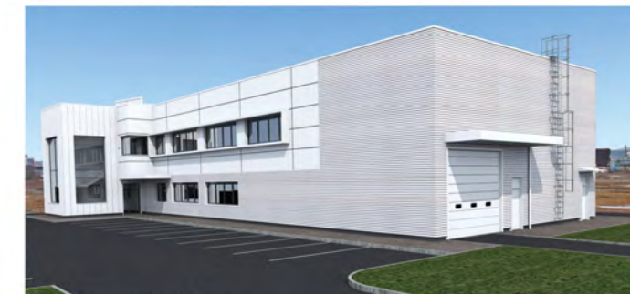
Entrée atelier montage
