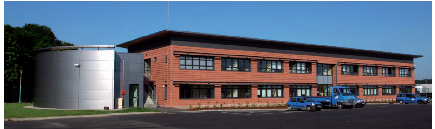
Vue générale bâtiment tertiaire
