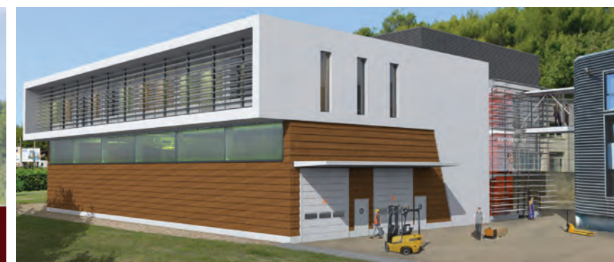
Bâtiment N° 12 ateliers/bureaux/archives
