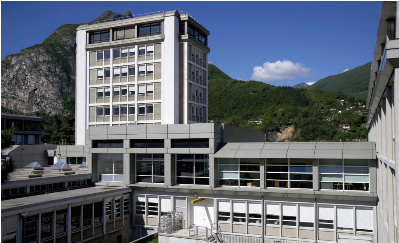
Surélévation / extension du bâtiment C1
