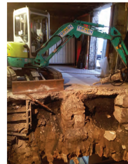
Détail sous-œuvre
