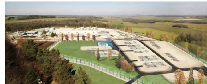
Restructuration du site industriel – Voisines (52)
