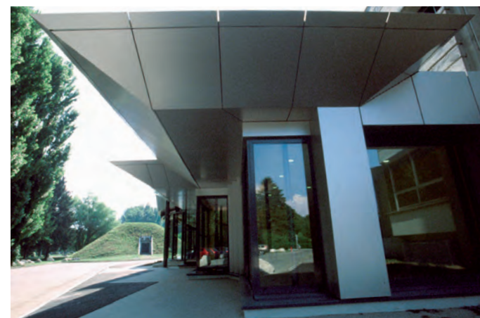
Extension du bâtiment – Façade est
