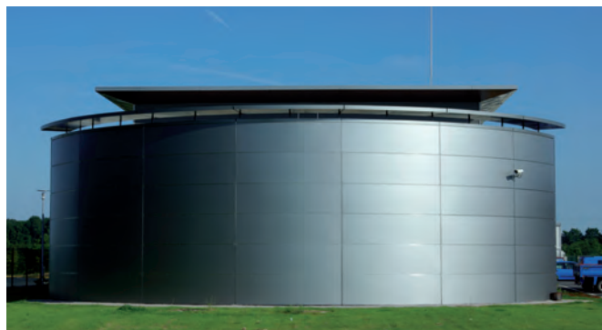
Détail façade de la salle de contrôle
