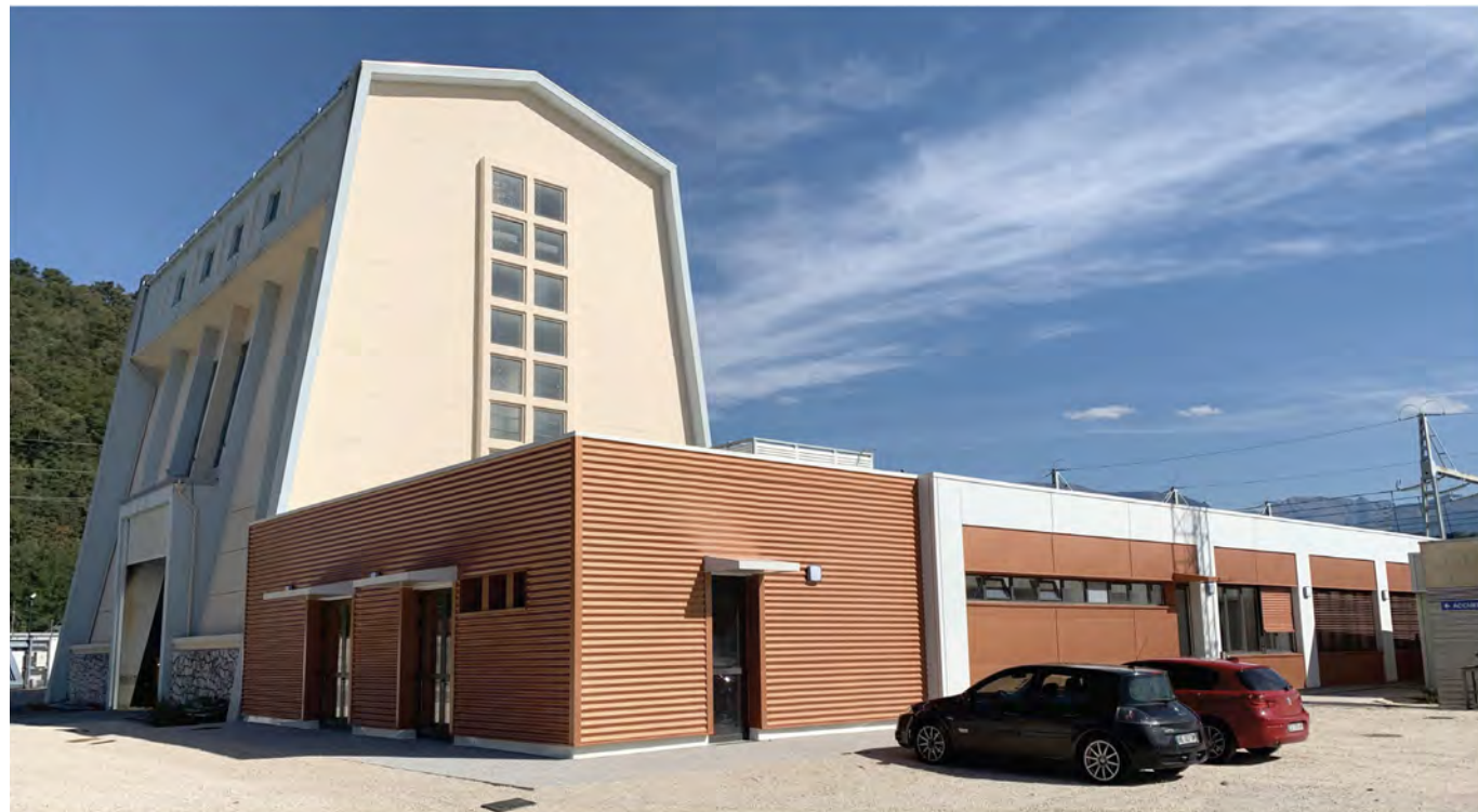
Bâtiment tertiaire/vestiaire/ateliers - Bâtiment 8 angle Nord-ouest
