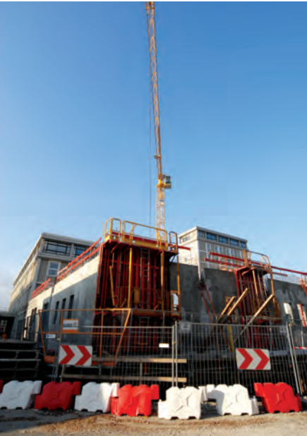
Détail chantier en 3 tranches
