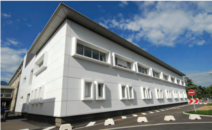
Vue sud-est du bâtiment « Z »
