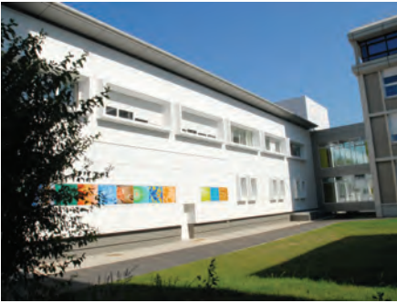
Détail façade ouest bâtiment scientifique Z
