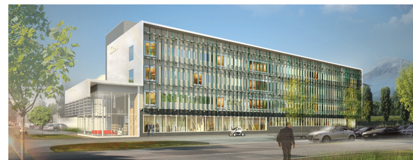
Vue générale du projet
