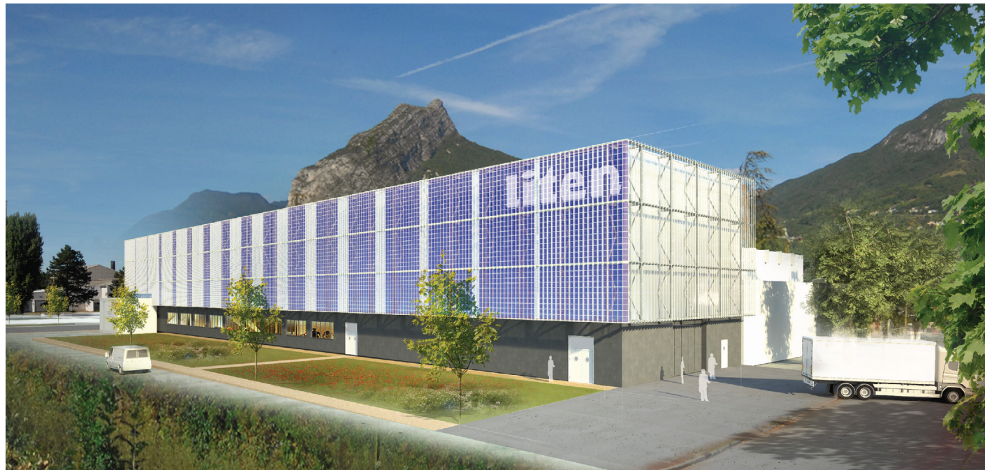
Liten – Halle technologique côté autoroute-CEA-TECH
