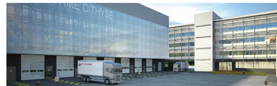
Halle technologique côté cour
