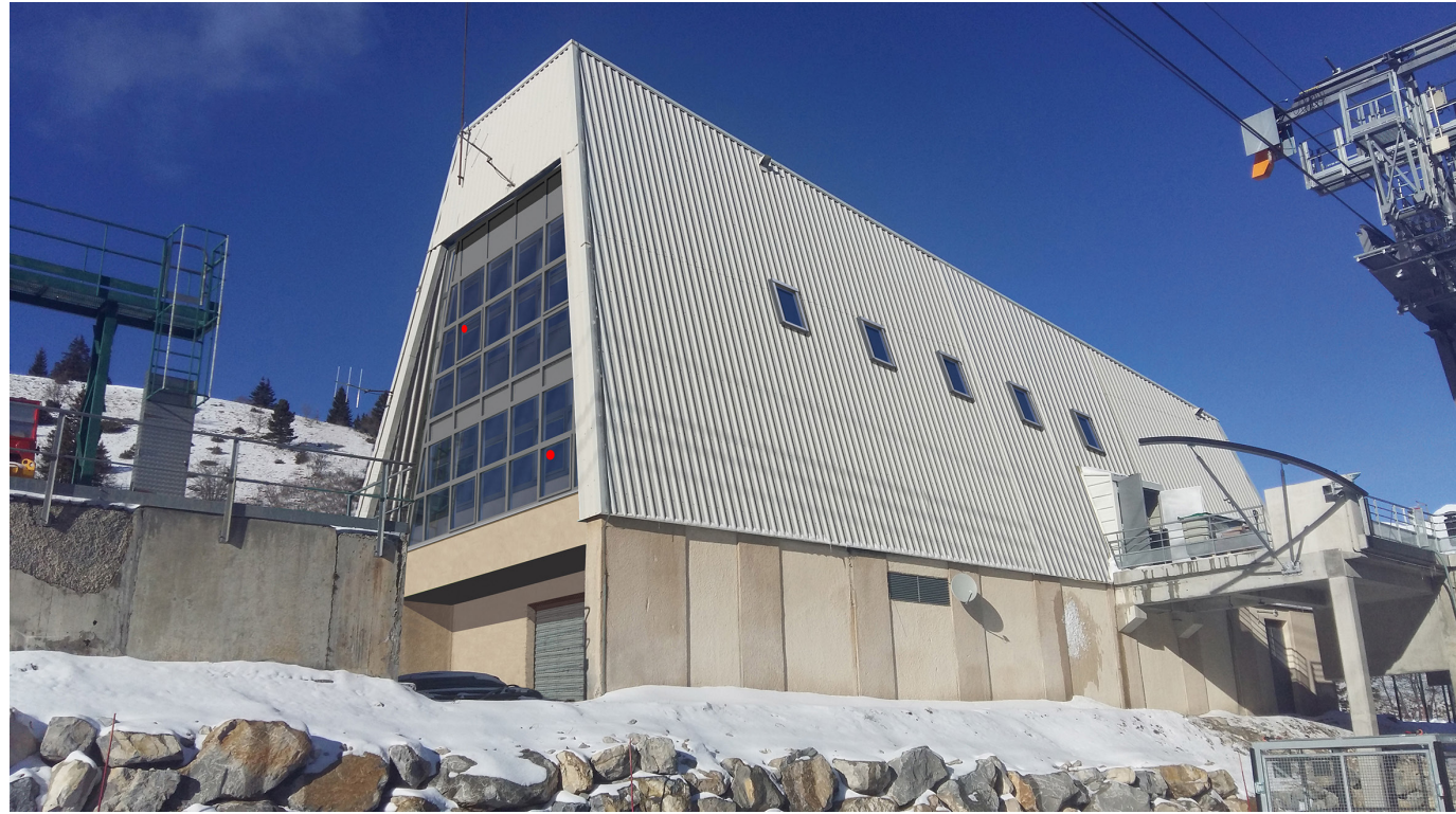
| Rénovation du clos couvert thermique / Insertion du projet dans le site
