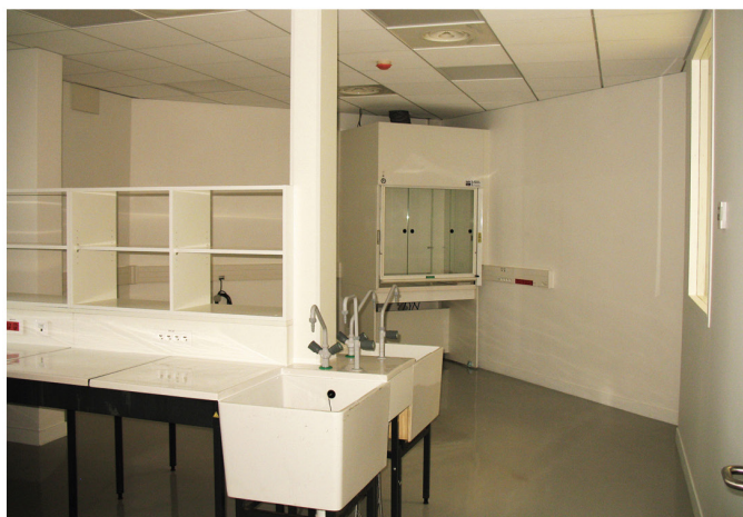
Mise en place des sorbonnes
