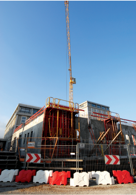
Détail chantier en 3 tranches
