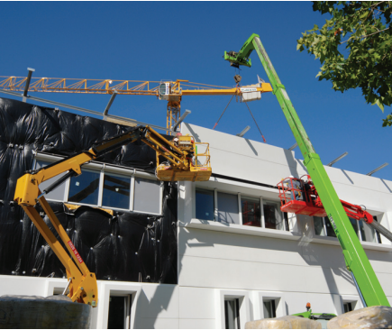
Montage des panneaux en CCV composite
