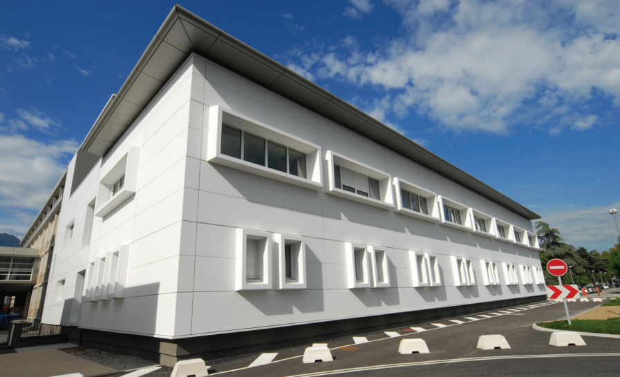
Vue sud-est du bâtiment « Z »
