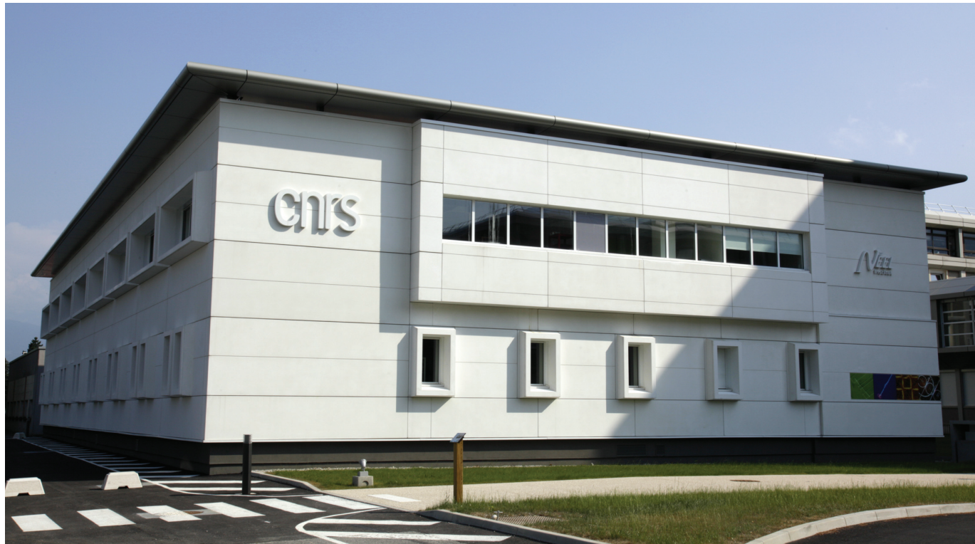
Fronton d'accueil du bâtiment scientifique « Z »
