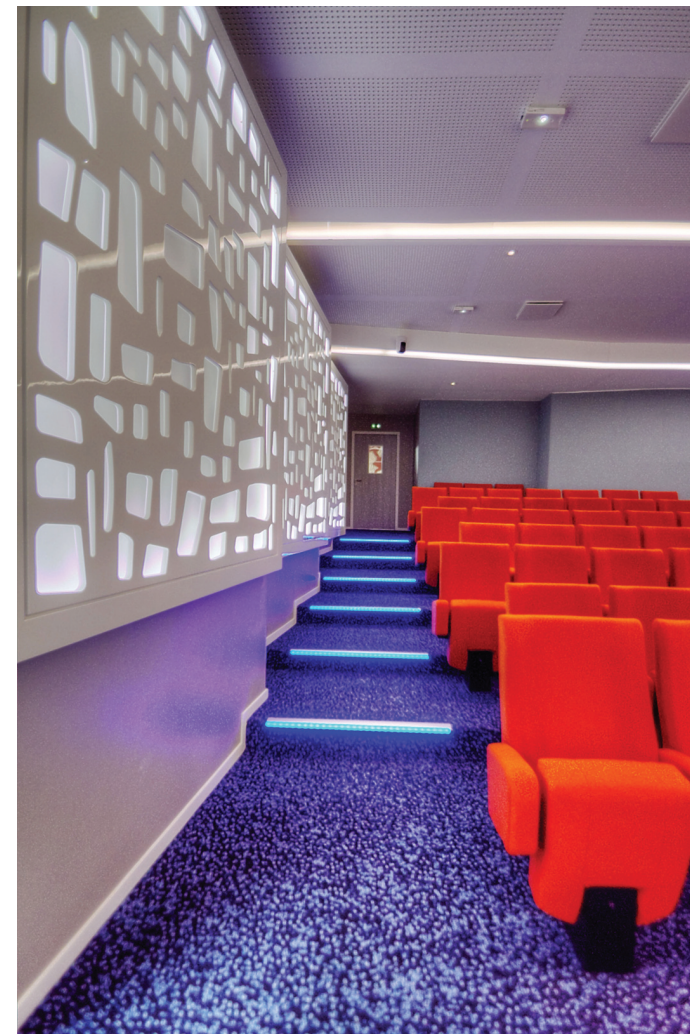
Détail des panneaux acoustiques décoratifs
