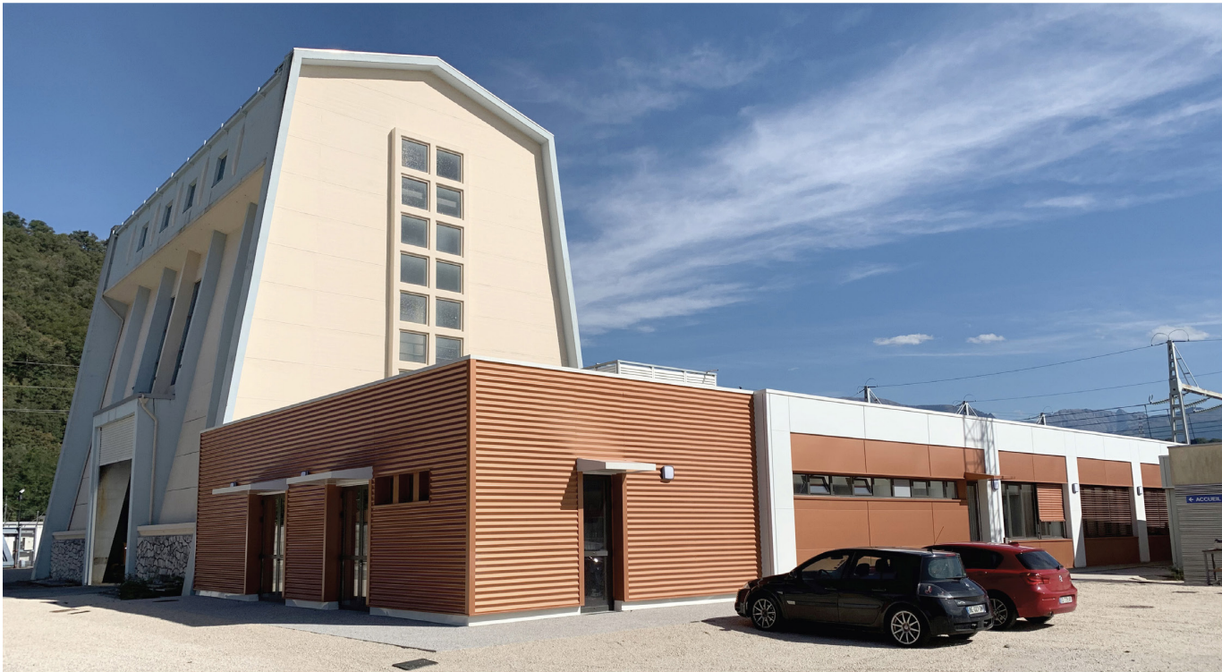
Bâtiment tertiaire/vestibaire/ateliers - Bâtiment 8 angle Nord-ouest
