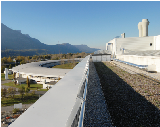
Toiture terrasse technique
