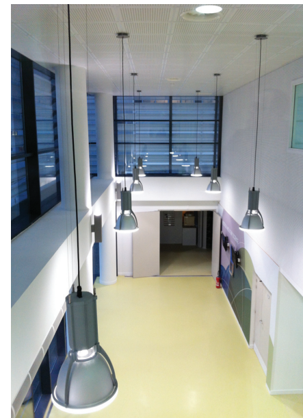
Vue sur hall d'entrée
