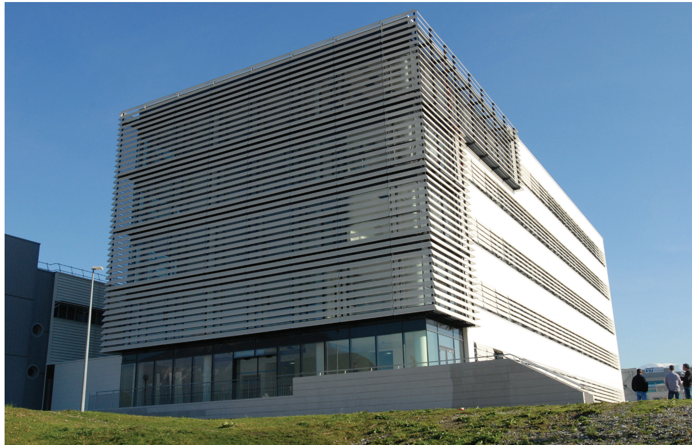
Vue du bâtiment « Science Building »
