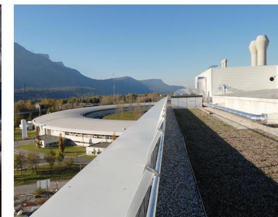
Toiture terrasse technique
