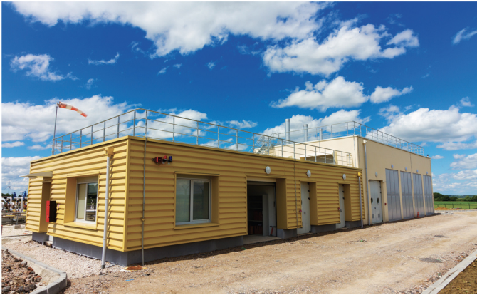
Bureaux et chaudière – Valhuon
