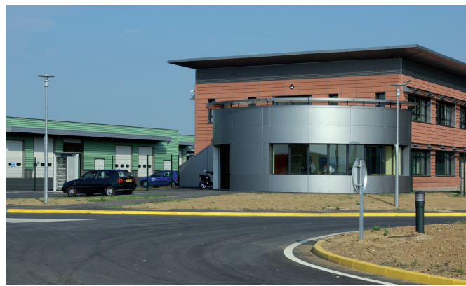
Détail poste de garde
