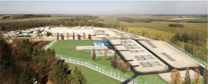
Restructuration du site industriel – Voisines (52)
