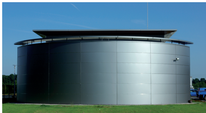
Détail façade de la salle de contrôle
