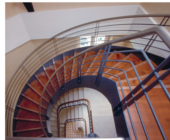
Extension de l'escalier d'honneur
